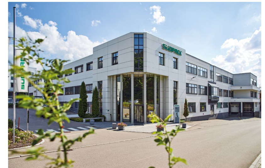
Zentrale von SÜDPACK Ochsenhausen
